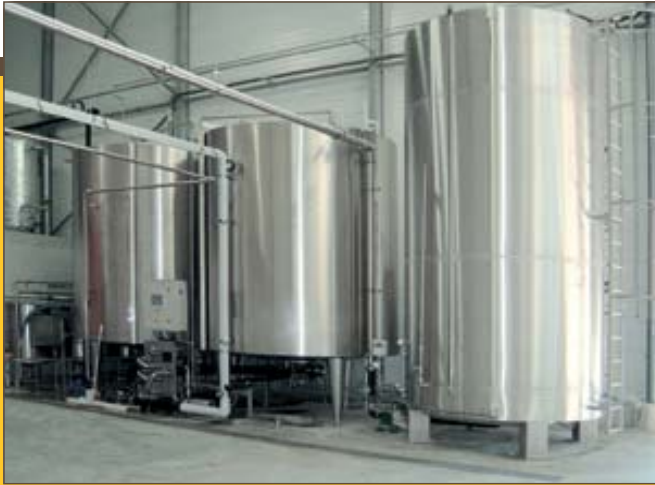
► EN Egg and glucose storage system SL Sistem skladiščenja jajc in glukoze HR Sistem uskladištenja jaja i glukoze PL System magazynowania jaj i glukozy RU Система складирования яиц и глюкозы ZH 蛋和葡萄糖儲存系統
